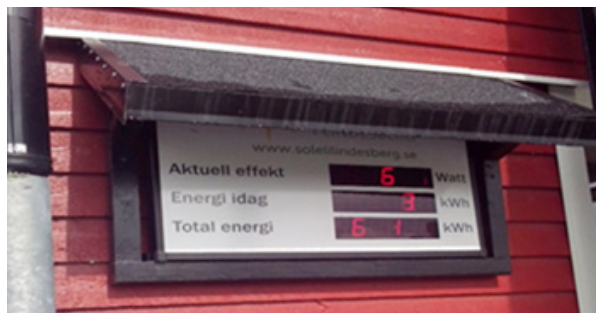
Display för solel visar aktuell effekt, dagens energiproduktion och produktion från driftstart
