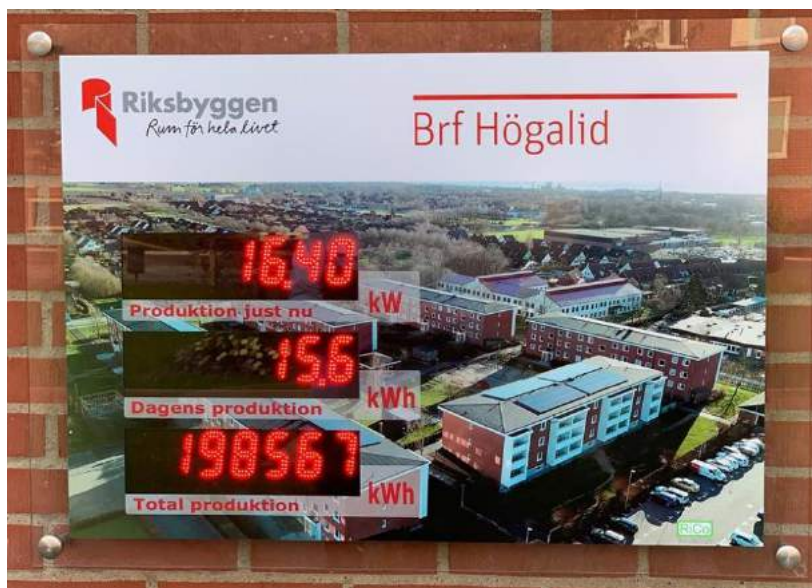
Figur 15 Display från RiCo som visar Brf Högalids solcellproduktion momentant och totalt
