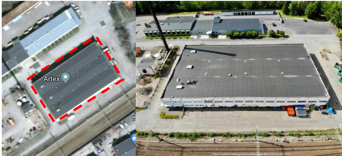
Figur 1 Skorstenen 3 från ovan.
