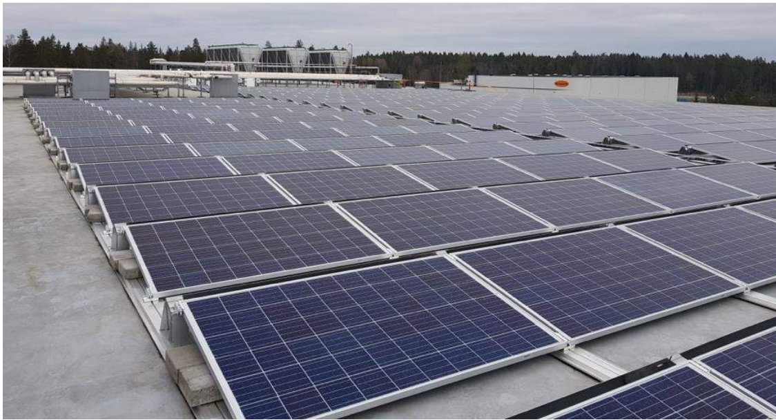
Figur 10 Monteringssystem för solceller med gatsten som ballast. Solcellsmodulerna på bilden lutar 10 grader, såsom föreslagen anläggning för Artex.
