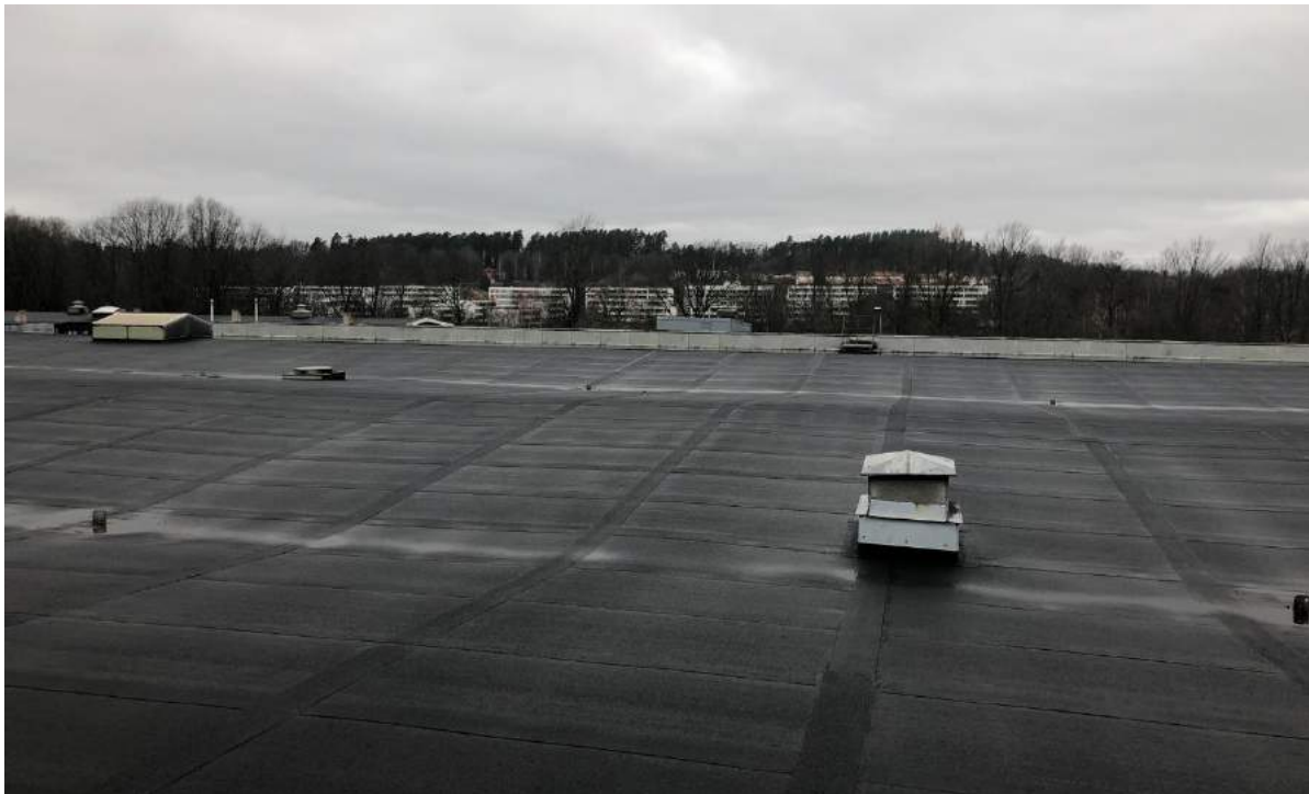
Figur 9 Artex tak som lutar 5 grader omvartannat i sex sektioner
