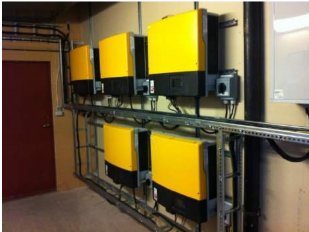
Figur 13 Exempel på installation med växeloriktare från SMA.
